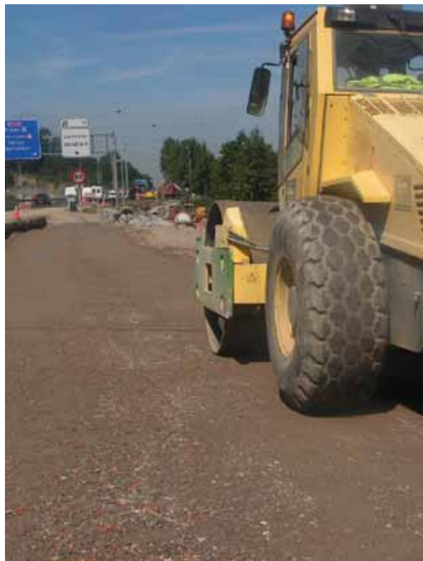
Compactación de la explanada. Tramo de prueba del Txorierrri.
