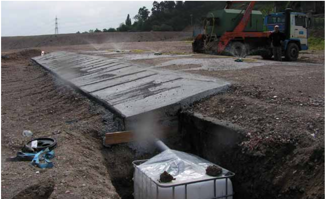
Figura 30. Tramo de prueba de la Orkonera.
